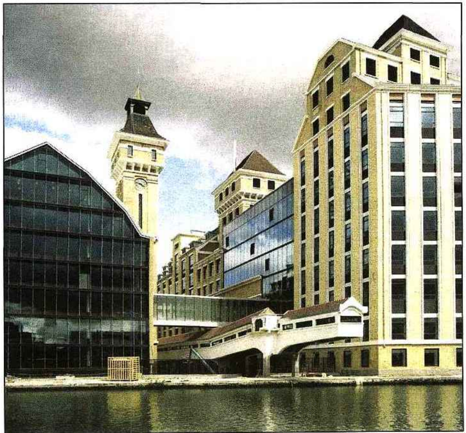
E.B. Les Grands-Moulins de Pantin rénovés ont reçu le label haute qualité environnementale. DR.
